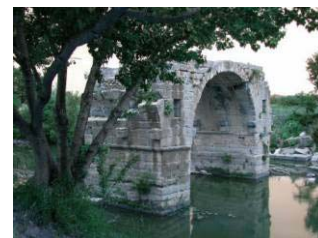
Vestige sur le site d'Ambrussum.
