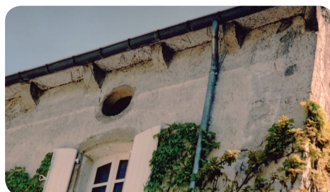
Débord bois sur corbeau grès
