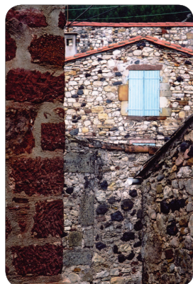
Lunas Appareillage tout venant, calcaire et basalte. Encadrement grès gris taillé. Chânage d'angle en grès rouge
