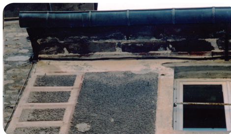
Double et triple rang de dalles minces de calcaire taillé (type tuillères) posées en tas-de-charge
