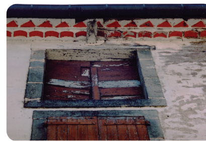
Simple rang de génoise sous double rang de brique plate
