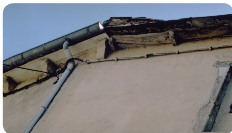
A gauche, platelage de bois sur corbeau grès. A droite, platelage bois sur débord de chevron surmonté d'un rang de dalles minces calcaires (type tuillères)
