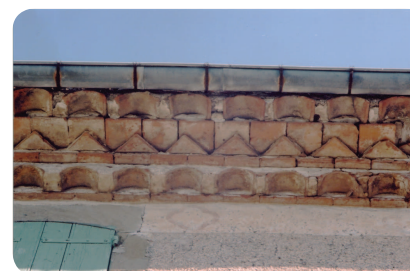
Deux rangs de génoise posées sur un rang de briques plates et séparées par trois rangs de carreaux de terre cuite
