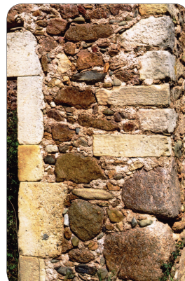
Taillevent Galet, pierres roulées, granit. Encadrement et chânage d'angle, grès clair taillé
