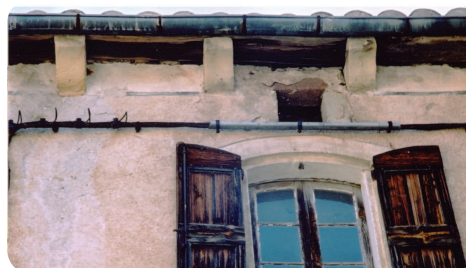
Débord bois sur corbeau grès
