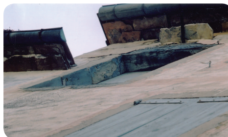
Débord bois sur corbeau grès
