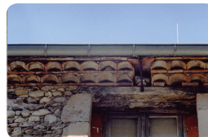
Double rang de génoise avec briques plates intercalées
