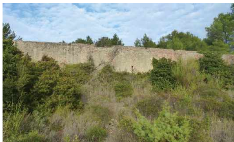
Bergerie en ruine dans le secteur de Cambelliès
