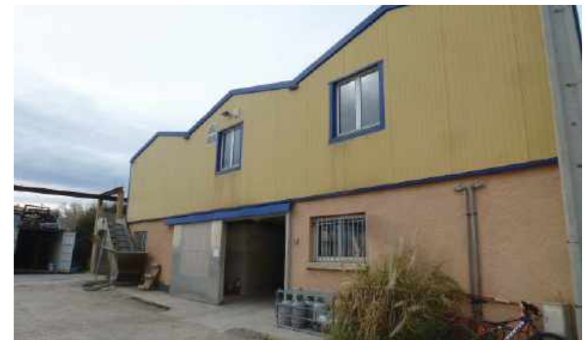
Hangar de grand volume et ses équipements annexes au cœur de la principale coupure d'urbanisation du secteur Centre-Nord
