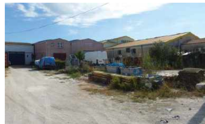
Vers le Sud, les grands bâtiments se multiplient en lien avec un terrain propice, plan et dégagé
