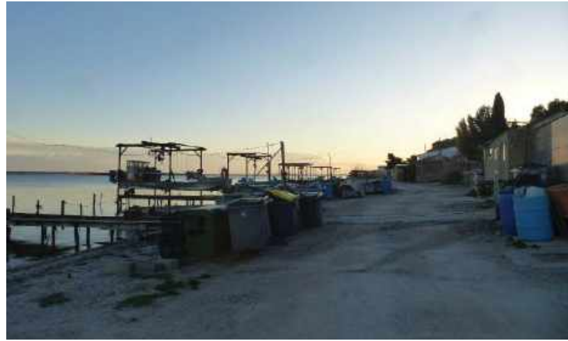
Desserte de la partie Nord par une voie située entre les bâtiments d'exploitation et la rive
