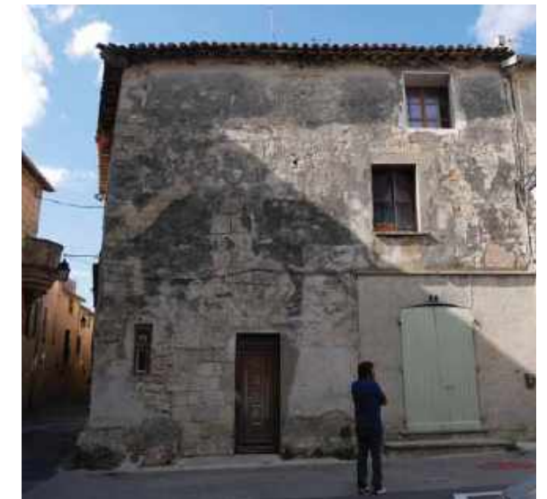
Vigilance sur les techniques de réhabilitation au regard des techniques constructives du bâti - pierre appareillée - moellons enduits
