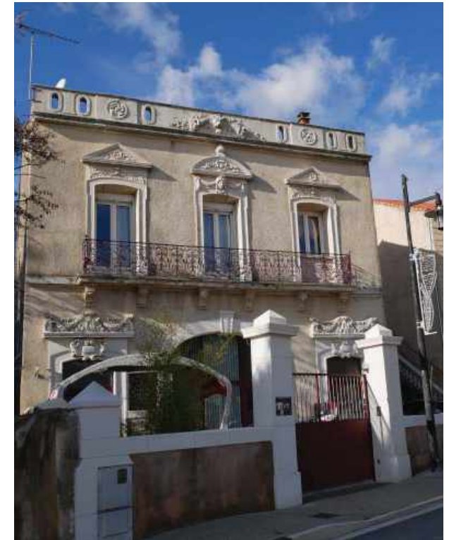
Maison vigneronne sur l'entrée de vile sud
