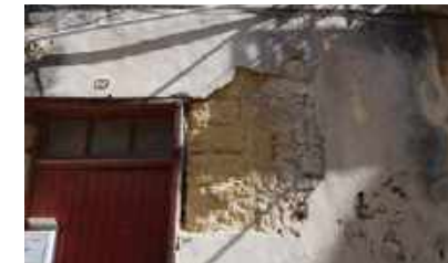
Vigilance sur les techniques de réhabilitation au regard des techniques constructives du bâti - pierre appareillée - moellons enduits
