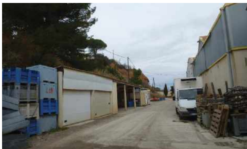
Des bâtiments adossés au talus (et autres conteneurs) au gré de son élargissement
