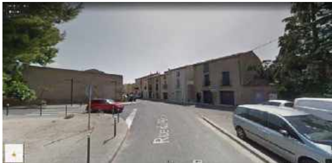
Entrée de ville Ouest par la rue du Pélican, non qualifiée. Présence de quelques d'arbres non alignés, fronts bâtis alignés et homogènes, chaussée différenciée. Travailler sur la signalisation, le mobilier urbain et le traitement végétal.
