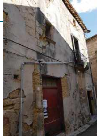
Vigilance sur les techniques de réhabilitation au regard des techniques constructives du bâti - pierre appareillée - moellons enduits
