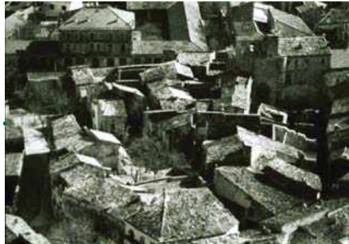
Le site du château vieux
