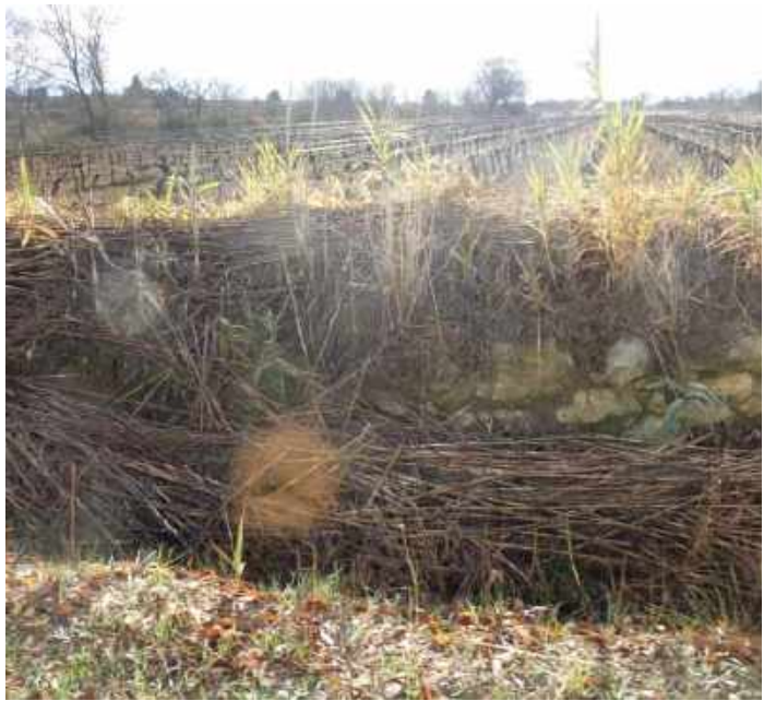
Les fossé bâtis, les murets de soutènement en pierre... un petit patrimoine menacé par le recalibrage des voies et des exutoires hydrauliques.
