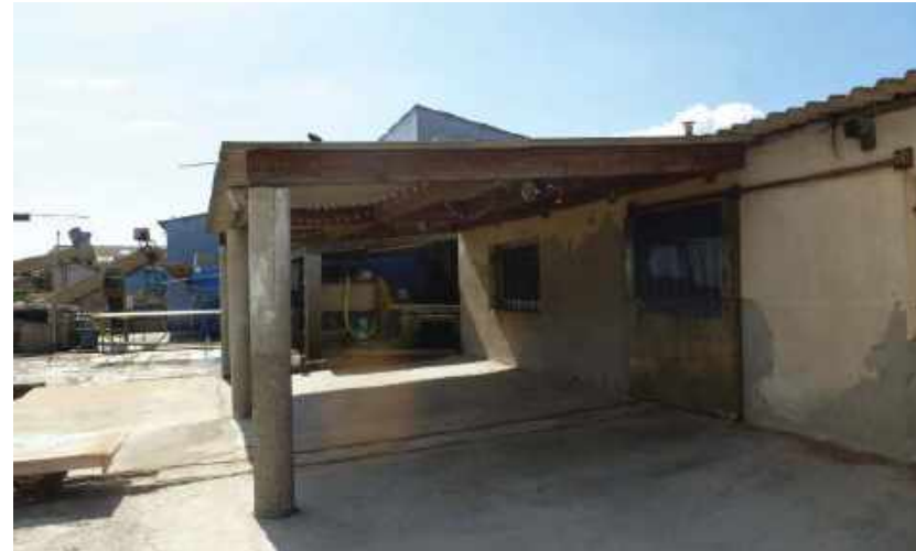
Les pergola sont des motifs récurrents : espace de travail ombragé et/ou de dégustation
