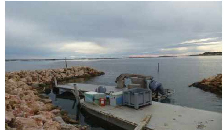
Les ouvrages défensifs (enrochements, digues...) caractérisent ce secteur et créent des espaces protégés pour les bateaux.
