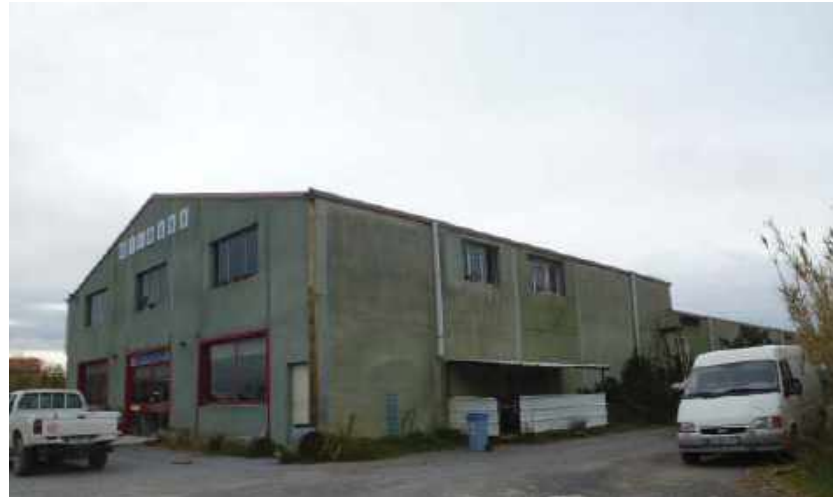
Le sous-ensemble Centre-Nord est agencé autour des ouvrages (digues et enrochements) et du bâtiment du chantier naval.
