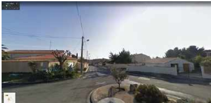
Entrée de ville Nord-Ouest, marquée par l'aménagement routier du rond point. Présence de quelques touches de végétation très anecdotiques. Travailler sur la signalisation, le mobilier urbain et un traitement végétal plus homogène et adapté.
