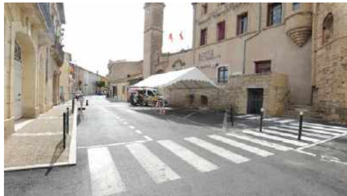
Rue Anatole France devant la mairie suite aux travaux
