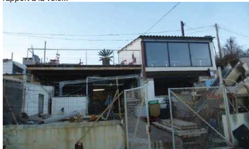
Des zones de travail et de stockage encombrées qui cohabitent avec des espaces dédiés à l'accueil du public (terrasse haute)
