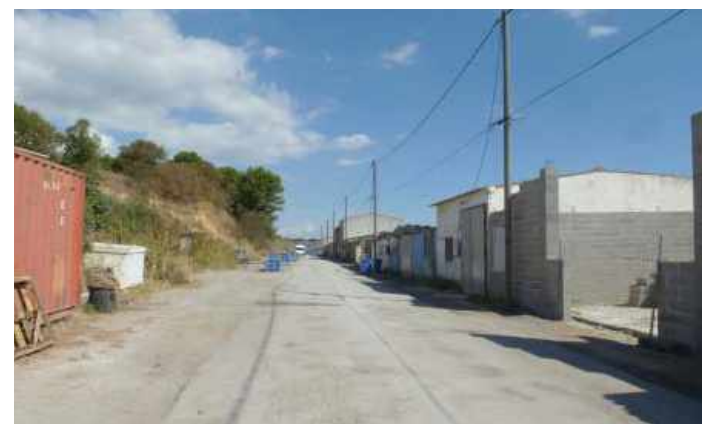
Desserte entre le talus végétalisé et les bâtiments d'exploitation à l'alignement
