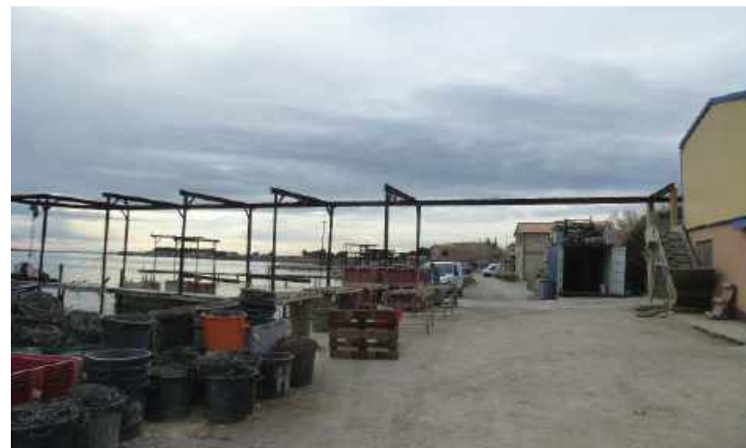
Hangar de grand volume et ses équipements annexes au cœur de la principale coupure d'urbanisation du secteur Centre-Nord
