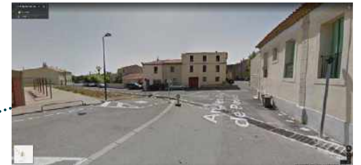
Entrée de ville Nord par l'ancienne route de Poussan, non qualifiée. Façades hétérogènes et alignements non marqués. Possibilité de s'appuyer sur la présence du centre socio-culturel Nelson Mandela. Travailler sur la signalisation, le mobilier urbain, la végétation (arbre haute tige) pour marquer les alignements et la chaussée.
