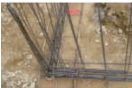
Nœud de chaînage - Continuité mécanique
