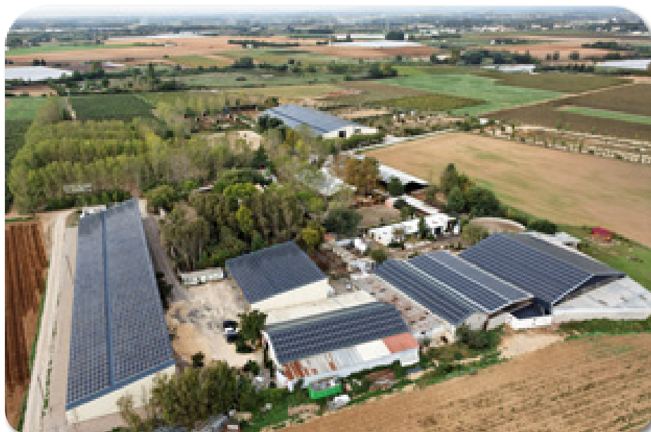
Exemple de projet photovoltaïque intégré en toiture de bâtiments agricoles sur la commune.
