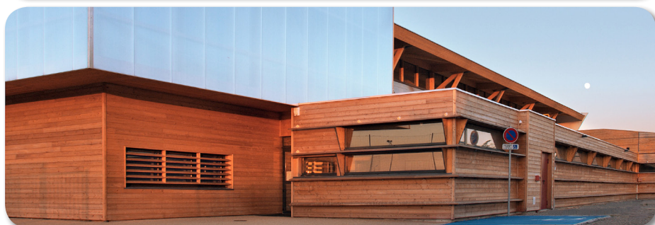
2 exemples d'architectures contemporaines durables sur la commune : le collège (P. Tourre architecte) et le gymnase (Architecture & environnement)
