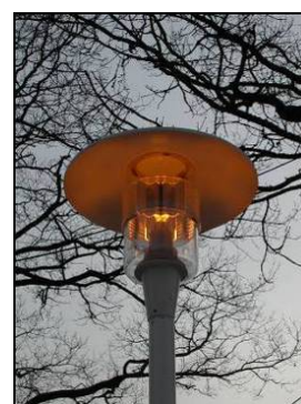
Focalisateurs supérieur et latéral dirigés vers une direction choisie
