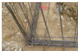
Noeud de chaînage - Continuité mécanique
