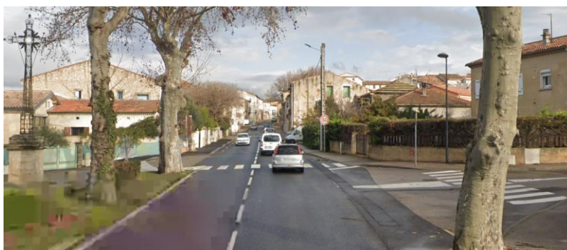
Route de Pézenas (RD32)
