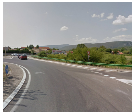
La carrefour giratoire en entrée de ville (RD999)
