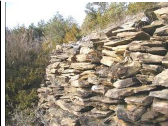
Mur de terrasse en pierre sèche
