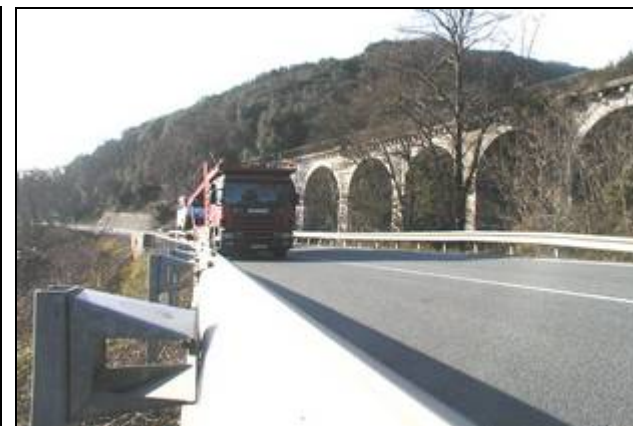
Viaduc ferroviaire, à la Fajolle
