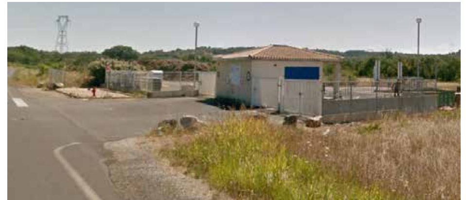
Vues vers l'est depuis la RD39, aux abords de la déchetterie accès principal depuis le site
