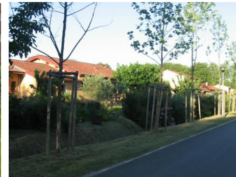
Exemple de noues en bordure de voie
