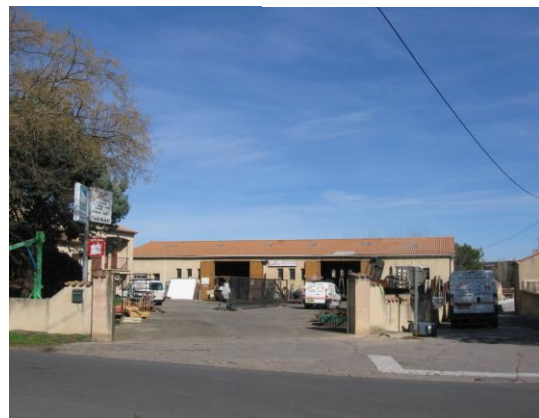
L'entreprise de ferronnerie, avenue de
