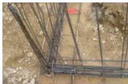
Nœud de chaînage - Continuité mécanique
