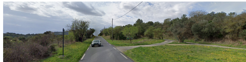
2/ Vues depuis la RD n°32 Vers Florensac
