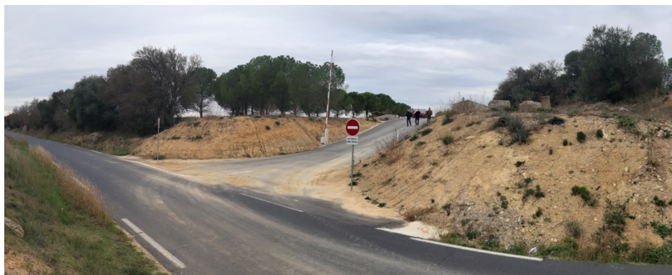
4/ Vue depuis la RD32 / Amélioration de l'accès vers les services techniques
