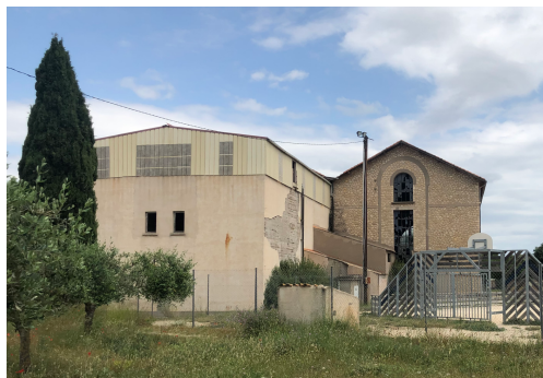
Cave coopérative Face arrière, comprenant une extension du début des années 1970 nuisible aux perceptions paysagères à ne pas conserver)
