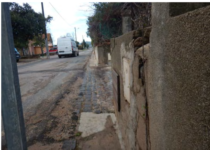
Illustration 5 : Exemple d'une voirie possédant un réseau pluvial limité (Chemin de Fouscais, source : Cereg)
