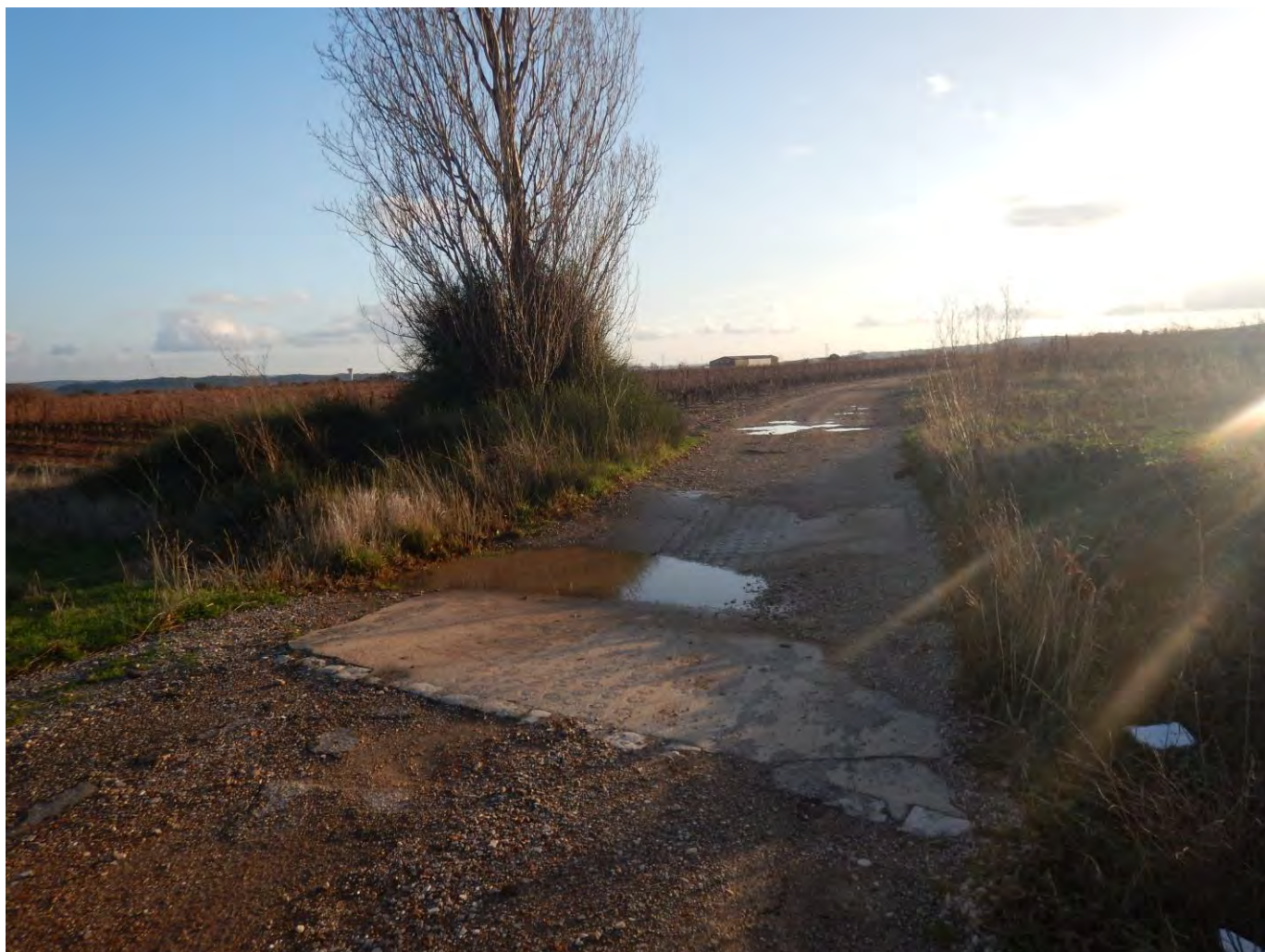
Illustration 20 Exutoire du Vallat du Mazéran – aval – Photo prise le 09/01/2018
