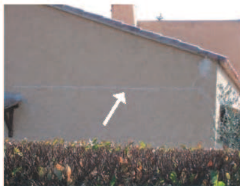
Fissuration traduisant un décollement de la structure par absence de liaisolement entre niveau bas et combles.
