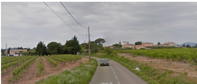
L'entrée de ville de Canet – RD130 Source : GoogleStreetView
