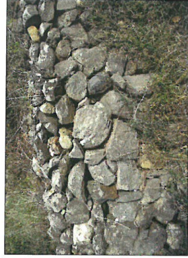
11. vieux mur en blocs de basalte
