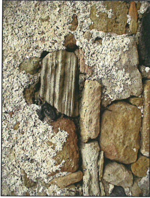
reste d'enduit à la chaux
