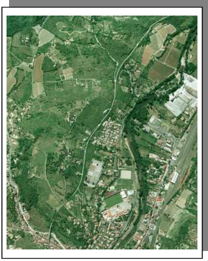
Vue aérienne de Bédarieux
