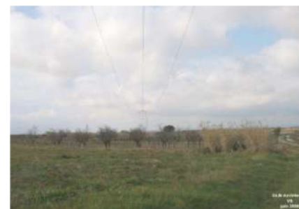
Ligne haute tension
