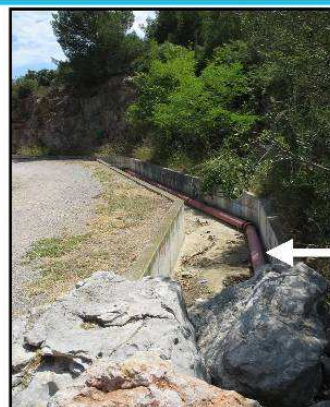
Vue canalette (Sud PPI) avec canalisation EU Utilisation pour le trop plein (2)
