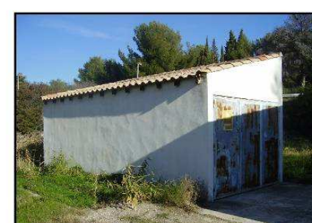
Vue bâtiment stockage chloration (17)
