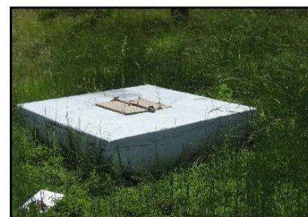
Vue ancien regard de visite (10)
