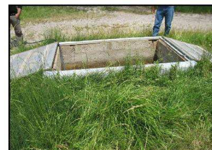
Vue regard de visite (11)
