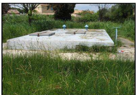
Vue ancienne bache de stockage N°1 (7)
