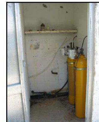
Vue branchement bouteille chlore (21)
