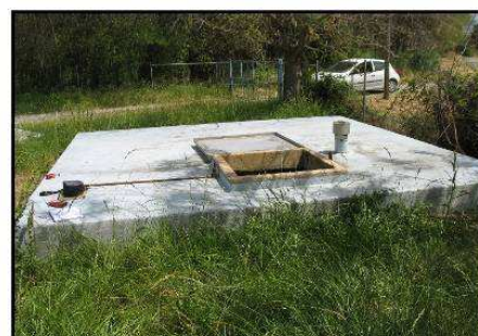
Vue ancienne bache de stockage N°2 (8)
