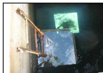
Vue accès ancienne bache de stockage N°2 (9)
