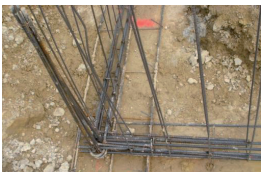
Noeud de chaînage - Continuité mécanique
