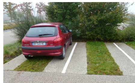
Traitement de sol perméable
