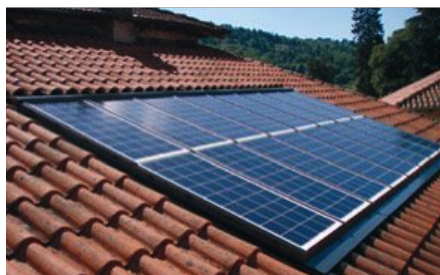
Implantations autorisée : intégrée à la toiture
