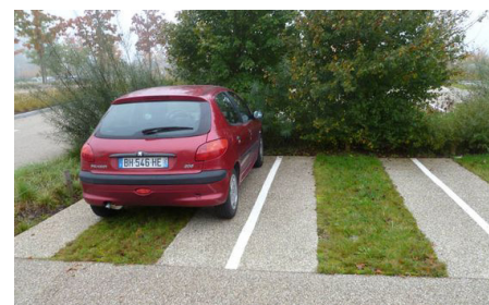
Traitement de sol perméable
