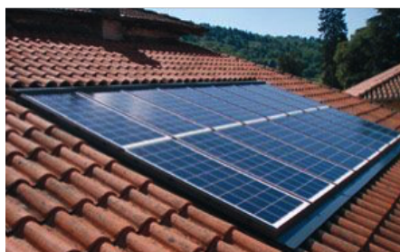
Implantations autorisée : intégrée à la toiture
