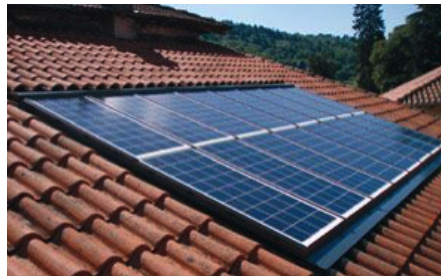
Implantations autorisée : intégrée à la toiture
