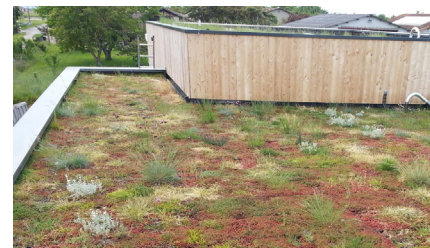
Végétalisation en toiture
