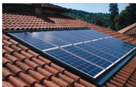
Implantations autorisée : intégrée à la toiture
