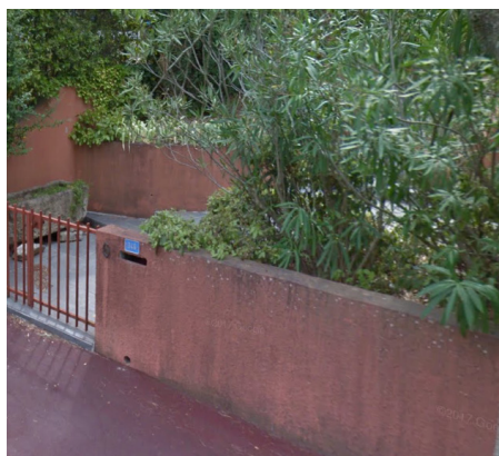
Clôture (mur doublé d'une haie vive)
