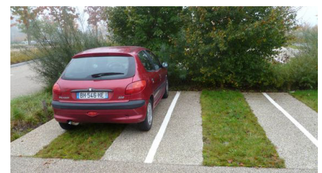
Traitement de sol perméable
