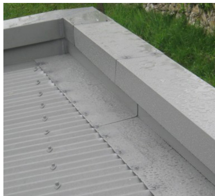
Couverture bac acier avec acrotère
