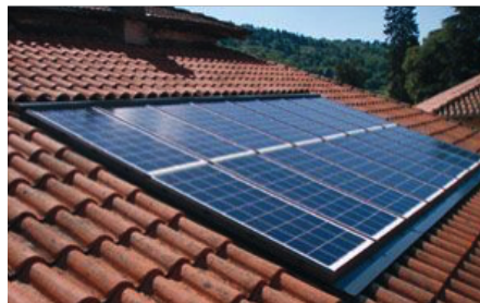
Implantations autorisée : intégrée à la toiture
