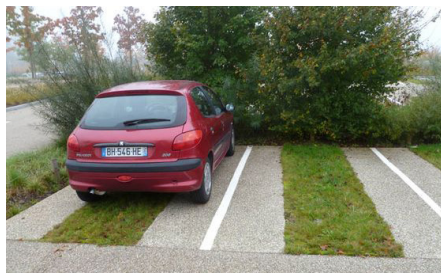
Traitement de sol perméable
