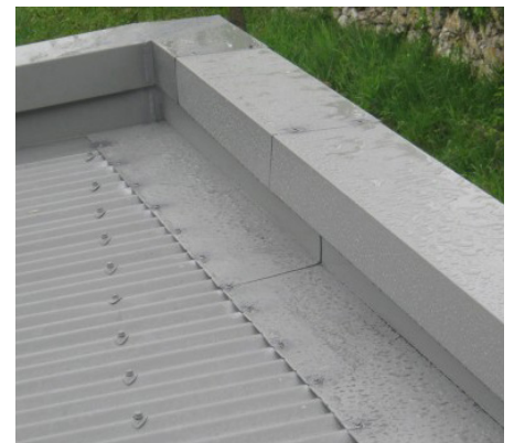
Couverture bac acier avec acrotère
