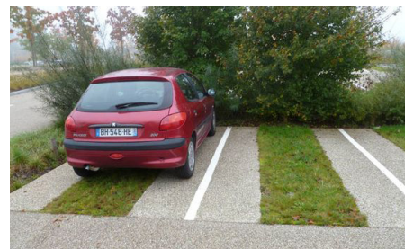
Traitement de sol perméable
