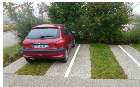
Traitement de sol perméable
