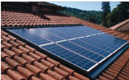
Implantations autorisée : intégrée à la toiture
