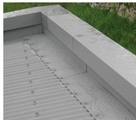
Couverture bac acier avec acrotère
