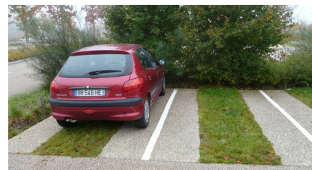
Traitement de sol perméable
