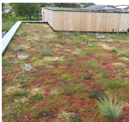
Végétalisation en toiture
