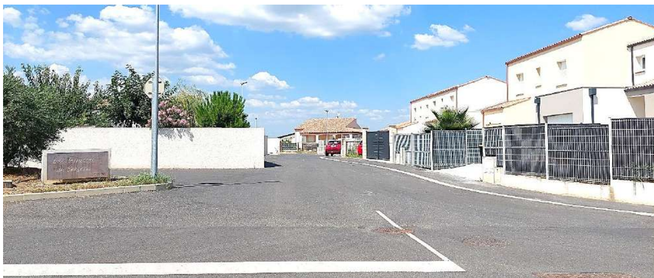
1 - Vue du projet réalisé depuis la rue de Brescou
