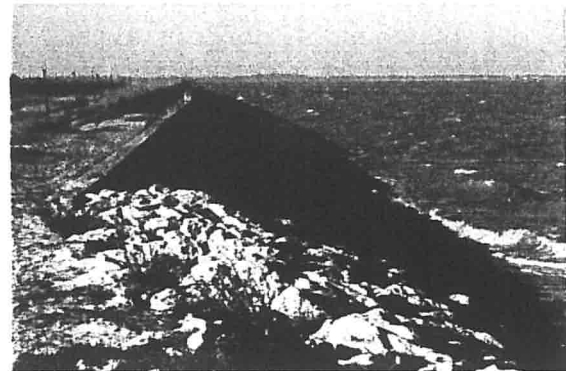
Digue maçonnée au lieu-dit la Plage. Commune de Saint-Vivien -de-Médoc
