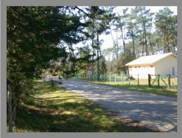
1 - Impact des constructions en bord de voie Passe du Tottoral.
