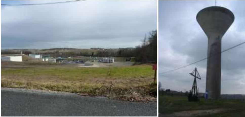
Différents points de vue disqualifiant les paysages de la commune : poste de gaz et château d'eau (quai de vigne en premier plan)
