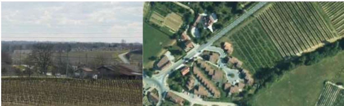
Perception de la bastide – Une façade urbaine de Sauveterre (nord-est) – logements sociaux
