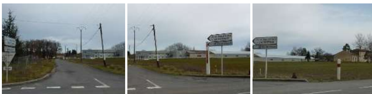
Vue de la zone de Gabachot depuis la RD 671
