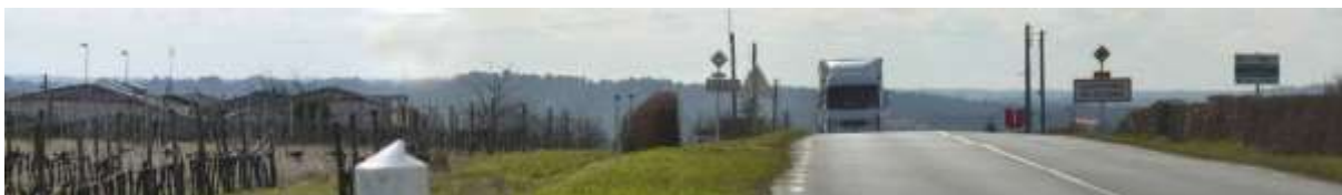
RD 670 au niveau de la future entrée commerciale du bourg, un effet de seuil se rajoutant au problème d'entrée de ville
