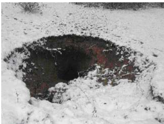
Effondrement d'une zone sous-cavée par suffosion (photo BRGM)
