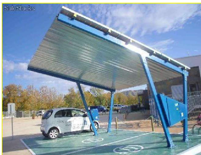
Toiture solaire pour recharge des bornes
