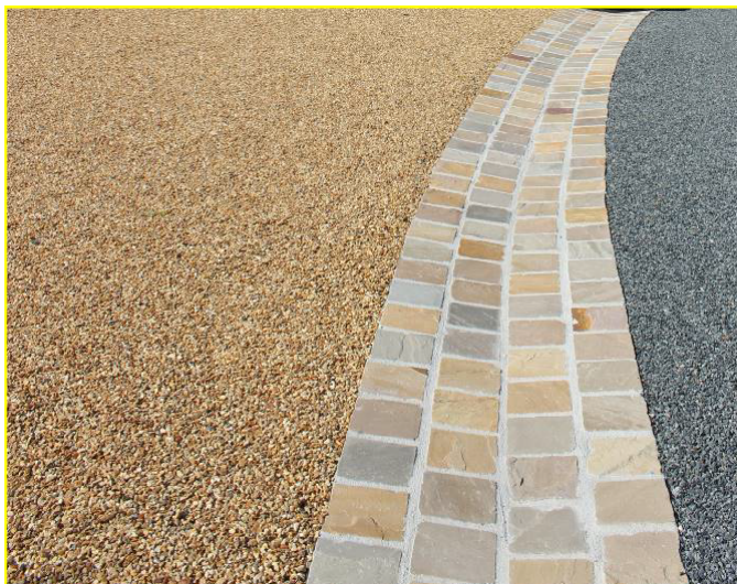
Caniveau pavé avec stabilisé
