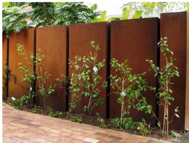
Mur métallique en acier corten
