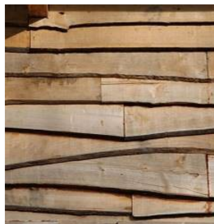
Bardage horizontal irrégulier
