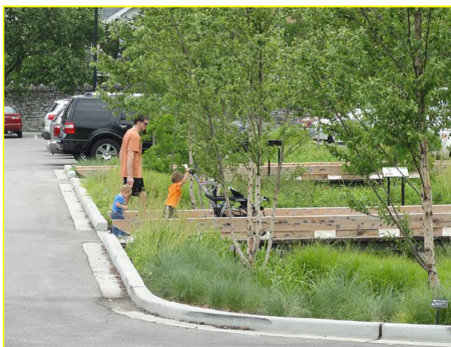
Parking paysager en béton bitumineux avec aménagement paysagers et traversées piétonnes marquées + jardin pluvial
