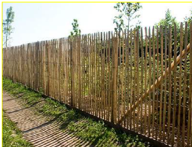
Clôture de ganivelle
