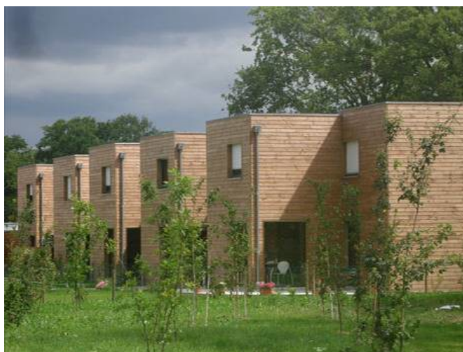
R+1 avec bardage bois toiture plate
