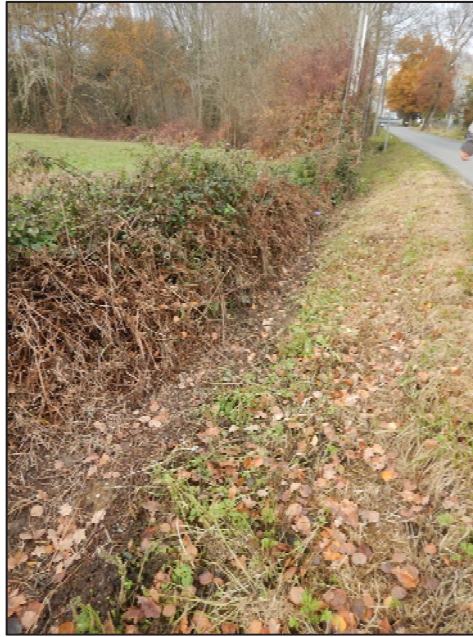
Figure 9 : Photographie du fossé au Nord du terrain
