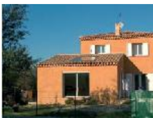
Intégré à la toiture de l'extension
