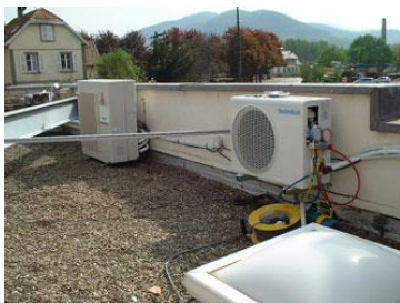
Sur le toit derrière un mur acrotère
