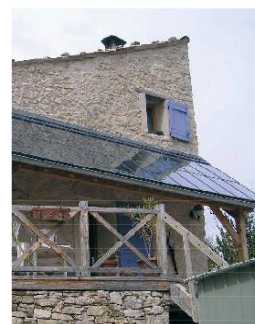
En couverture d'une pergola
