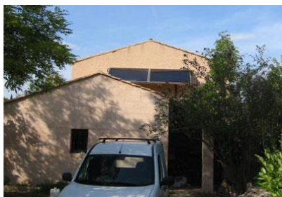
En garde-corps au-dessus d'un pan de toit
