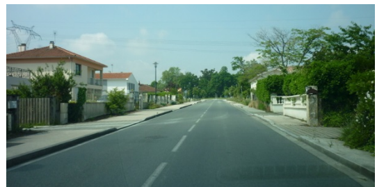
Requalification de la rue Blouin et de l'avenue Pousson
