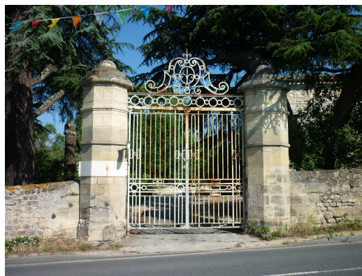
portail d'entrée du château Montijon
