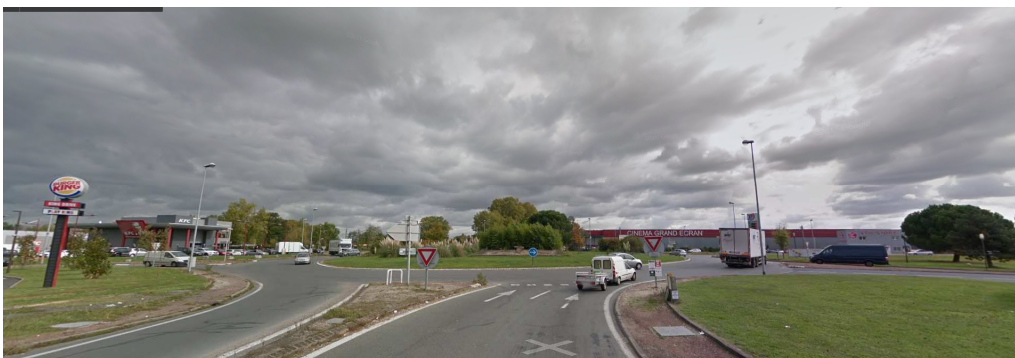
L'entrée de ville sur le rond-point reliant l'échangeur 43 à l'avenue de l'Aquitaine
