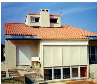
Sur les avancées de toit en brise soleil
