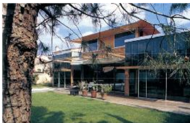
Elément de composition de la façade
