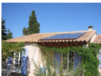
Sur l'arrière du bâti
