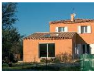
Intégré à la toiture de l'extension
