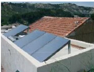
Derrière un mur acrotère en toiture
