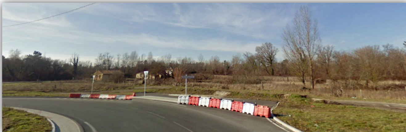
Vue sur l'entrée de la zone, au niveau de la RD1010
