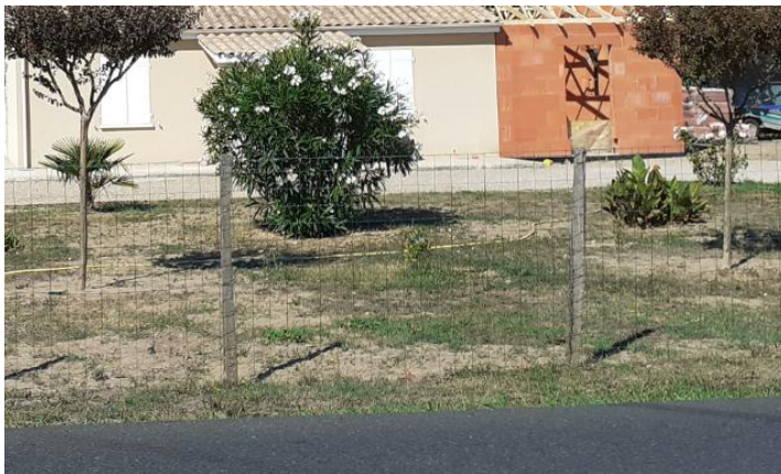
Grillage (perméable à l'eau)
