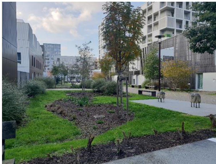
Figure 3 : Exemple de noue de rétention – cas N°5
