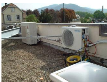
Sur le toit derrière un mur acrotère
