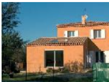
Intégré à la toiture de l'extension
