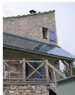
En couverture d'une pergola
