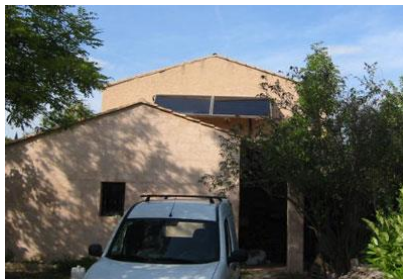
En garde-corps au-dessus d'un pan de toit
