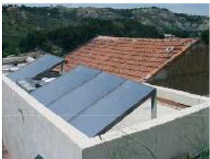
Derrière un mur acrotère en toiture
