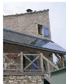
En couverture d'une pergola
