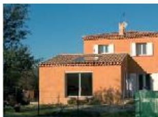
Intégré à la toiture de l'extension
