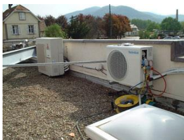
Sur le toit derrière un mur acrotère
