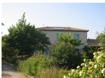
Discret en façade vue de la rue
