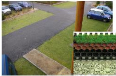
parking dalles alvéolaires enherbées
