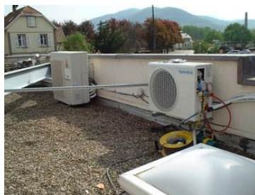
Sur le toit derrière un mur acrotère
