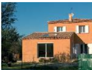
Intégré à la toiture de l'extension
