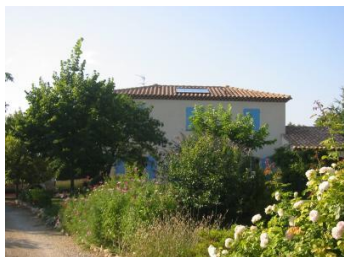
Discret en façade vue de la rue
