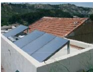
Derrière un mur acrotère en toiture
