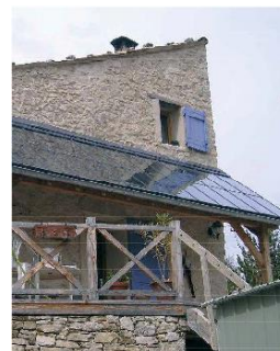
En couverture d'une pergola
