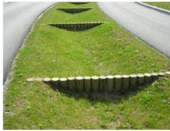
Figure 5 – Ouvrage enterré : rétention en structure alvéolaire ultra légère Figure 6 – Ouvrage de surface : noue d'infiltration
