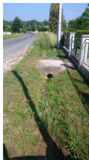
Figure 11 - Tampon ensablé au rond-point du lieu-dit Reys (droite) et fossé encombré par des hautes herbes à l'allée Perrucade (gauche)
