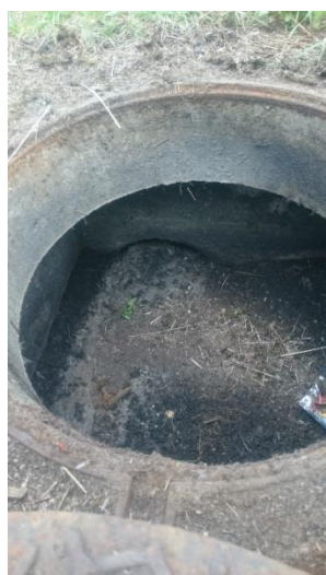
Figure 11 - Tampon ensablé au rond-point du lieu-dit Reys (droite) et fossé encombré par des hautes herbes à l'allée Perrucade (gauche)
