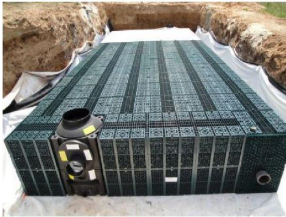
Figure 5 – Ouvrage enterré : rétention en structure alvéolaire ultra légère Figure 6 – Ouvrage de surface : noue d'infiltration
