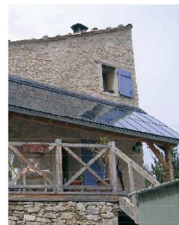
En couverture d'une pergola
