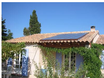
Sur l'arrière du bâti
