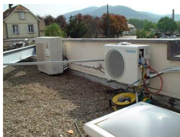
Sur le toit derrière un mur acrotère
