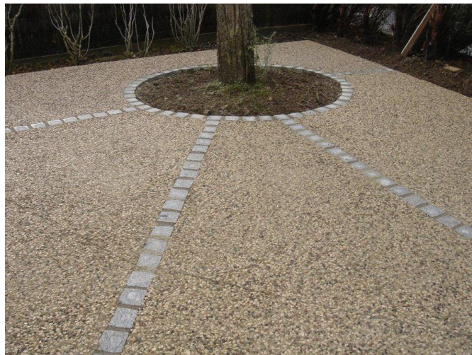
Exemple de sol en béton désactivé avec joint de dilatation en pavé
