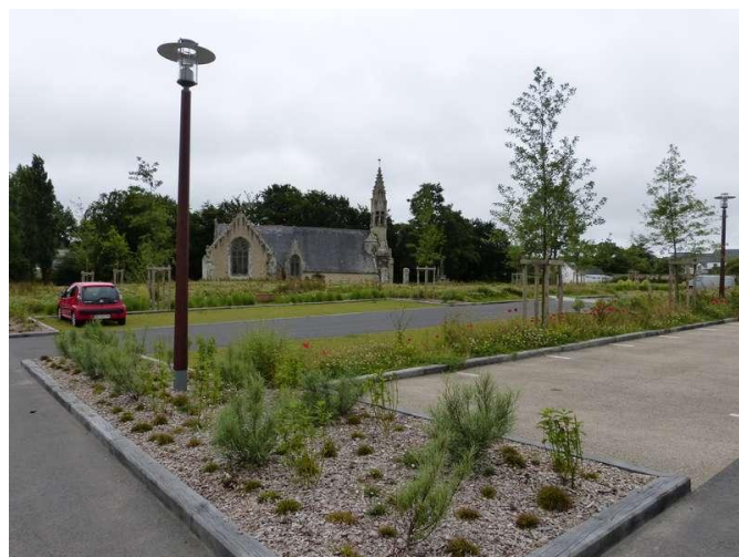
Parking paysager : voie en béton bitumineux clair et emplacements en stabilisé avec plantations, bordure en traverses de chemin de fer
