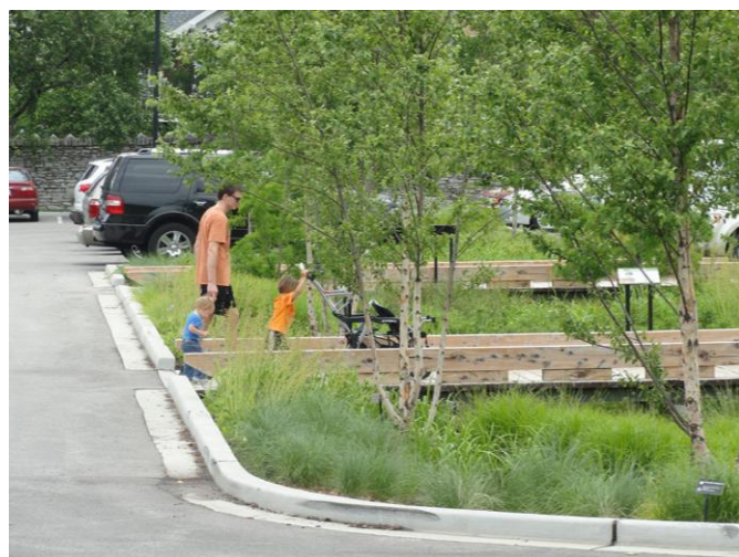
Parking paysager en béton bitumineux avec aménagement paysagers et traversées piétonnes marquées + jardin pluvial
