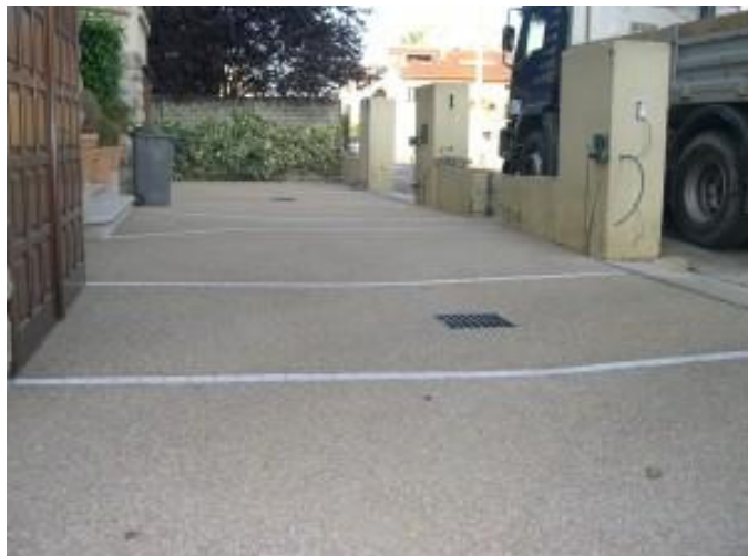
Exemple de sol en béton désactivé avec joint de dilatation en pavé
