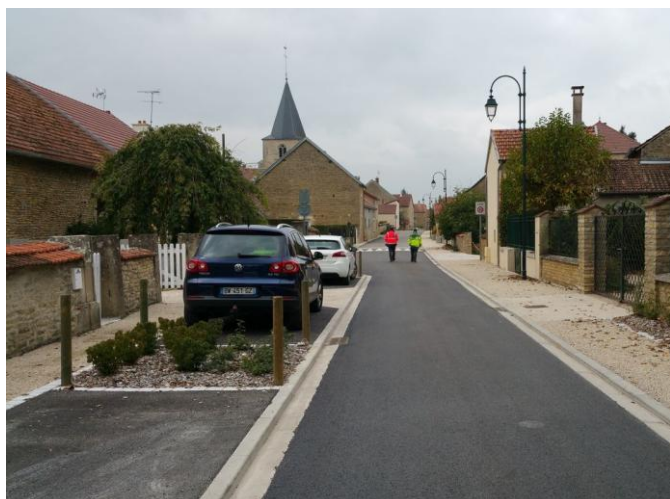
Rue avec stationnement longitudinal, travail soigné des bordures, revêtements, caniveaux, plantations
