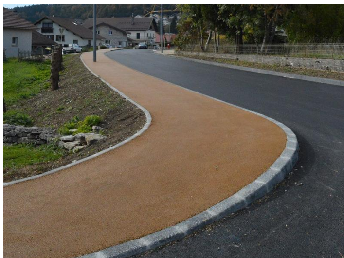
Exemple de bordure en béton
