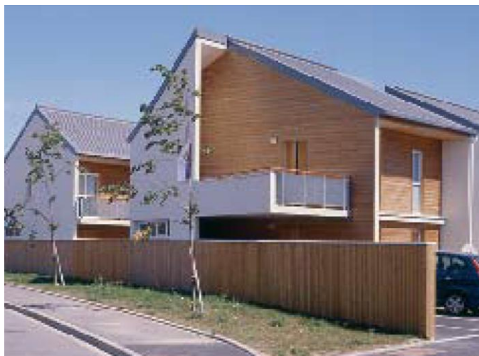
R+1 avec toiture
