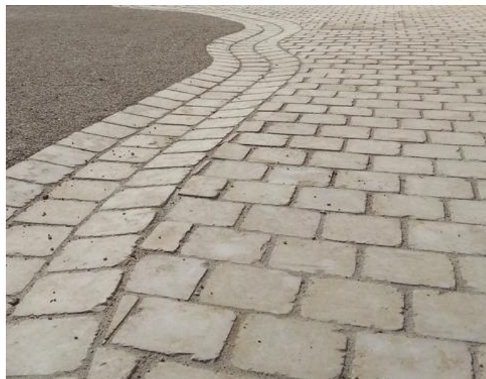
Caniveau avec pavés / dalle
