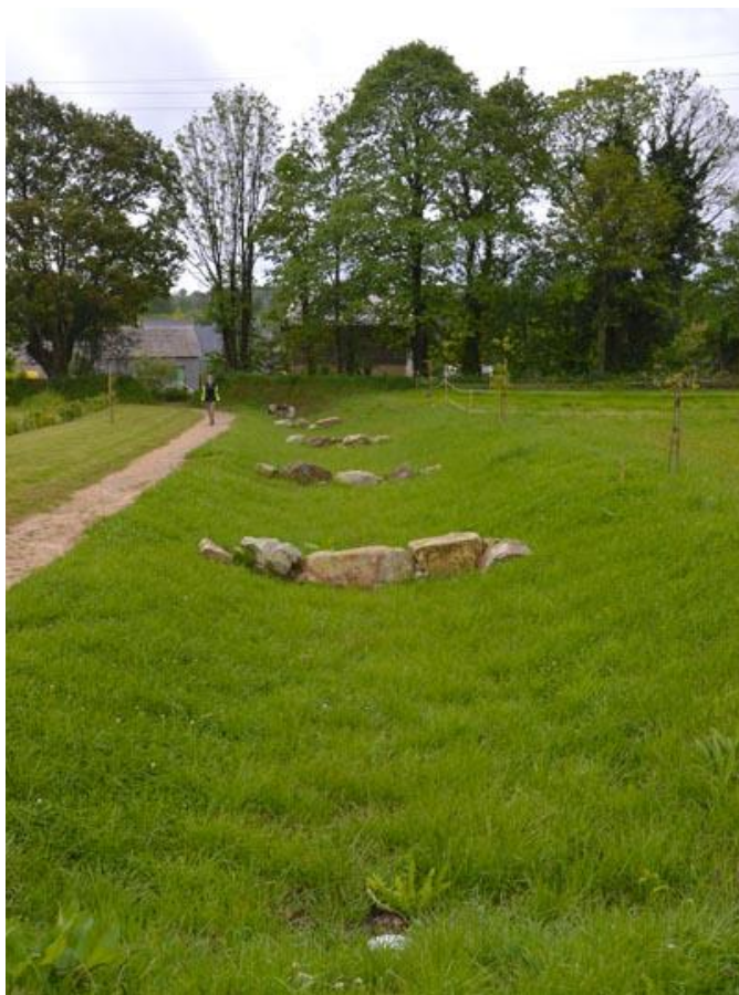
Noue en abord de parc
