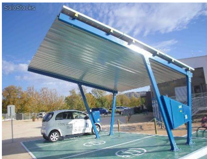
Toiture solaire pour recharge des bornes
