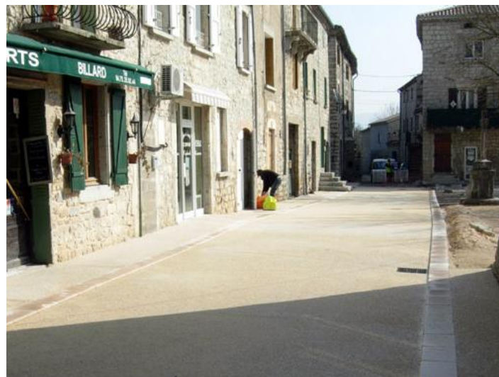
Exemple d'enrobé grenaillé clair et trottoir à niveau en béton désactivé
