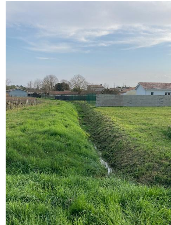
Zone n°2 des Gunes, drainée par un fossé en lien avec la Jalle du Breuil
