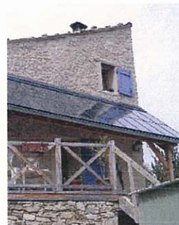
En couverture d'une pergola
