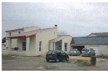
Continuité de façade
