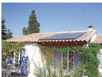
Sur l'arrière du bâti
