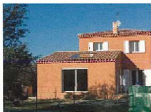
Intégré à la toiture de l'extension
