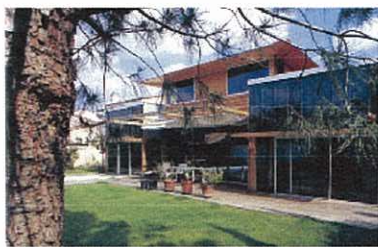
Elément de composition de la façade
