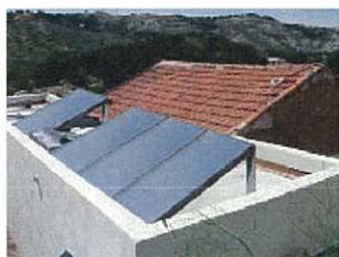
Derrière un mur acrotère en toiture
