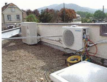
Sur le toit derrière un mur acrotère
