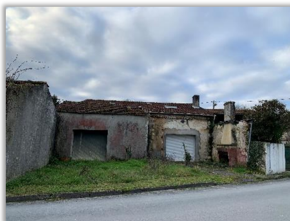
Des ensembles bâtis dégradés
