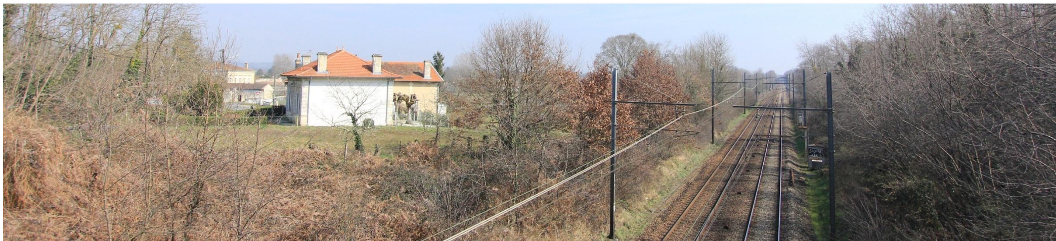
Les grands axes forment aussi des ouvertures au sein de la forêt, ce sont des « clairières linéaires » qui marquent des limites. La voie ferrée définit la frontière Sud du Bourg, cette limite stricte doit elle être franchie ?
