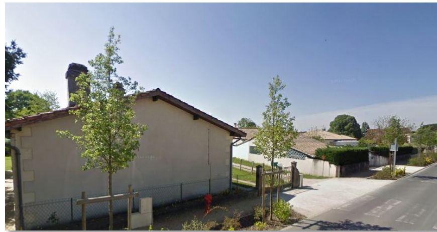
Front de rue avec aménagement de l'espace public qualitatif malgré la mixité des types de clôtures – Avenue du Général de Gaulle
