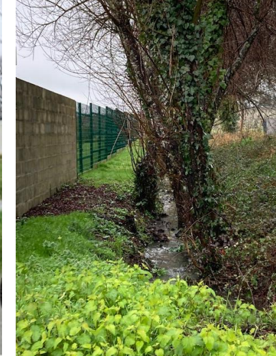
Fossé d'évacuation des eaux pluviales du plateau viticole au nord de la route de Cagnac, entre deux parcelles bâties
