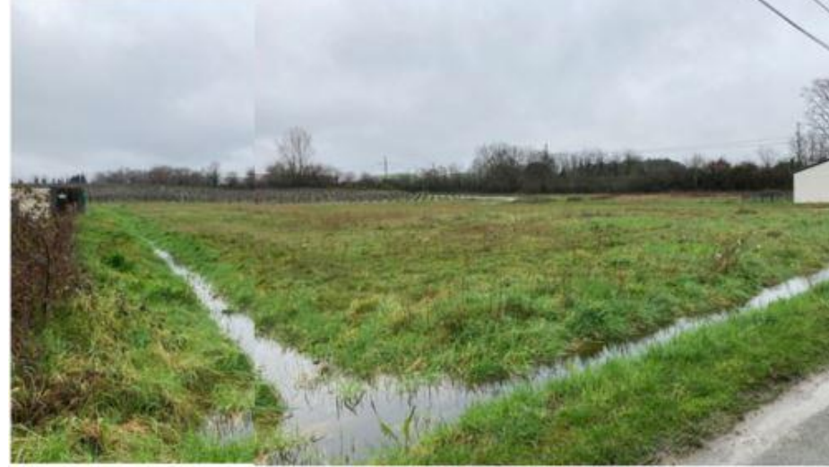
Fossé d'évacuation des eaux pluviales du plateau viticole au nord de la route de Cagnac
