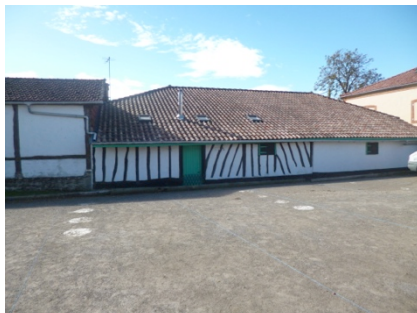
Bâtisse de plain-pied avec combles
