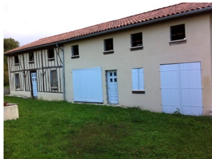
Bâti rénové en cohérence avec le bâti ancien
