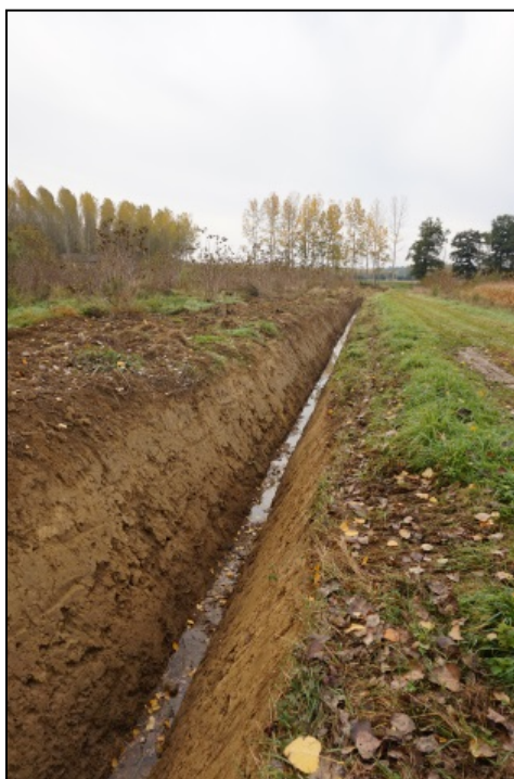
Fossés à nu à gauche et fossé végétalisé avec espèces végétales hygrophiles à droite (Urgosse, 2015) © ETEN Environnement
